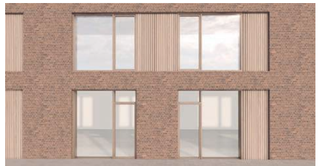
Hotel facade med murværksstruktur og træbeklædning
